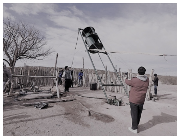
Figura 2. Montaje del molino. (Chrestia et al., 2015)
