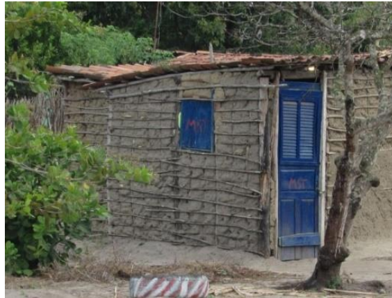
Figura 3. Casa de taipa, construção de pau a pique
